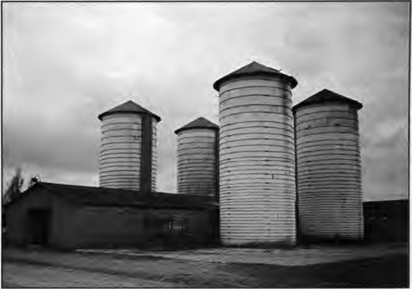
FIGURA 2.12 SILOS TORRES (CENTRO DE INVESTIGACIONES AGROPECUARIAS DE TIBAITATÁ, MOSQUERA, CUNDINAMARCA)
