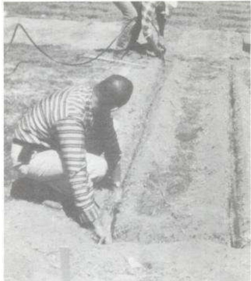
*La expansión de las áreas de cultivo, implica el estudio de métodos más eficientes para la distribución y aprovechamiento del agua para riego. En la gráfica un ingeniero agrónomo dispone la instalación de tubería para riego subterráneo.*
