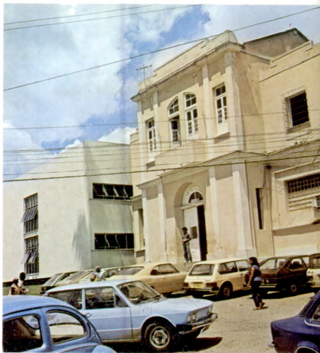
A Santa Casa da Misericórdia de Itabuna foi reformada e ampliada com a ajuda da CEPLAC.
