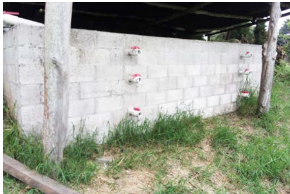
► Pila de tratamiento de aguas mieles. Cordillera Apaneca Ilamatepec. Foto: CSC
