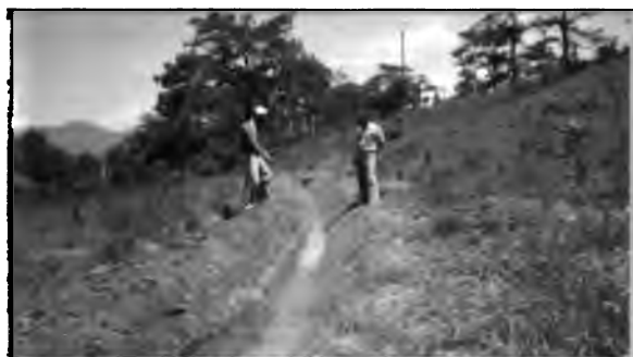
Acequia de Ladera tipo trinchera
