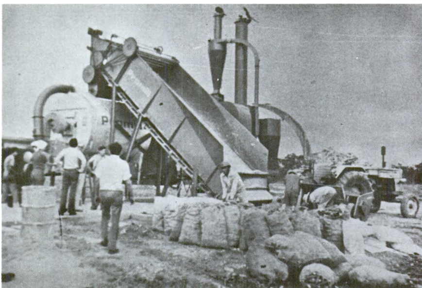
Fig. 86. Secador rotativo o de tambor en uso experimental en el secado de raíces de yuca.
