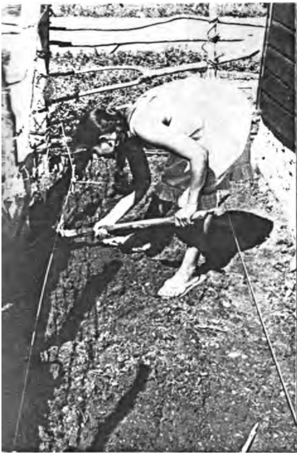
PIQUE ALREDEDOR DEL HILO HACIENDO UNA ZANJA
