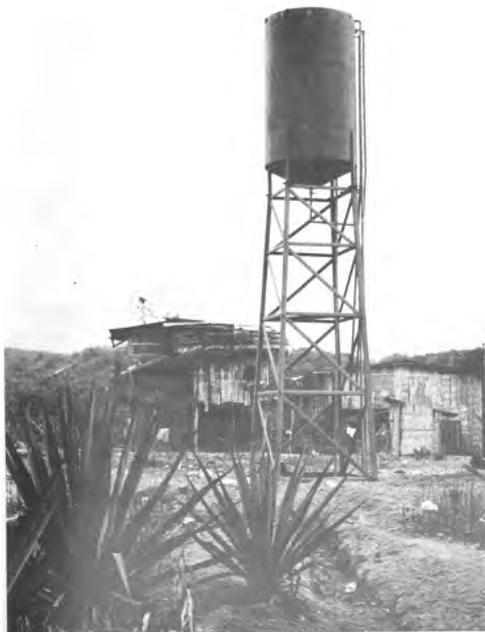
Abastos de agua como el de Motete contribuyen a solucionar el grave problema de escasez del vital líquido y a mejorar la condición sanitaria en el Cantón Jipijapa.
