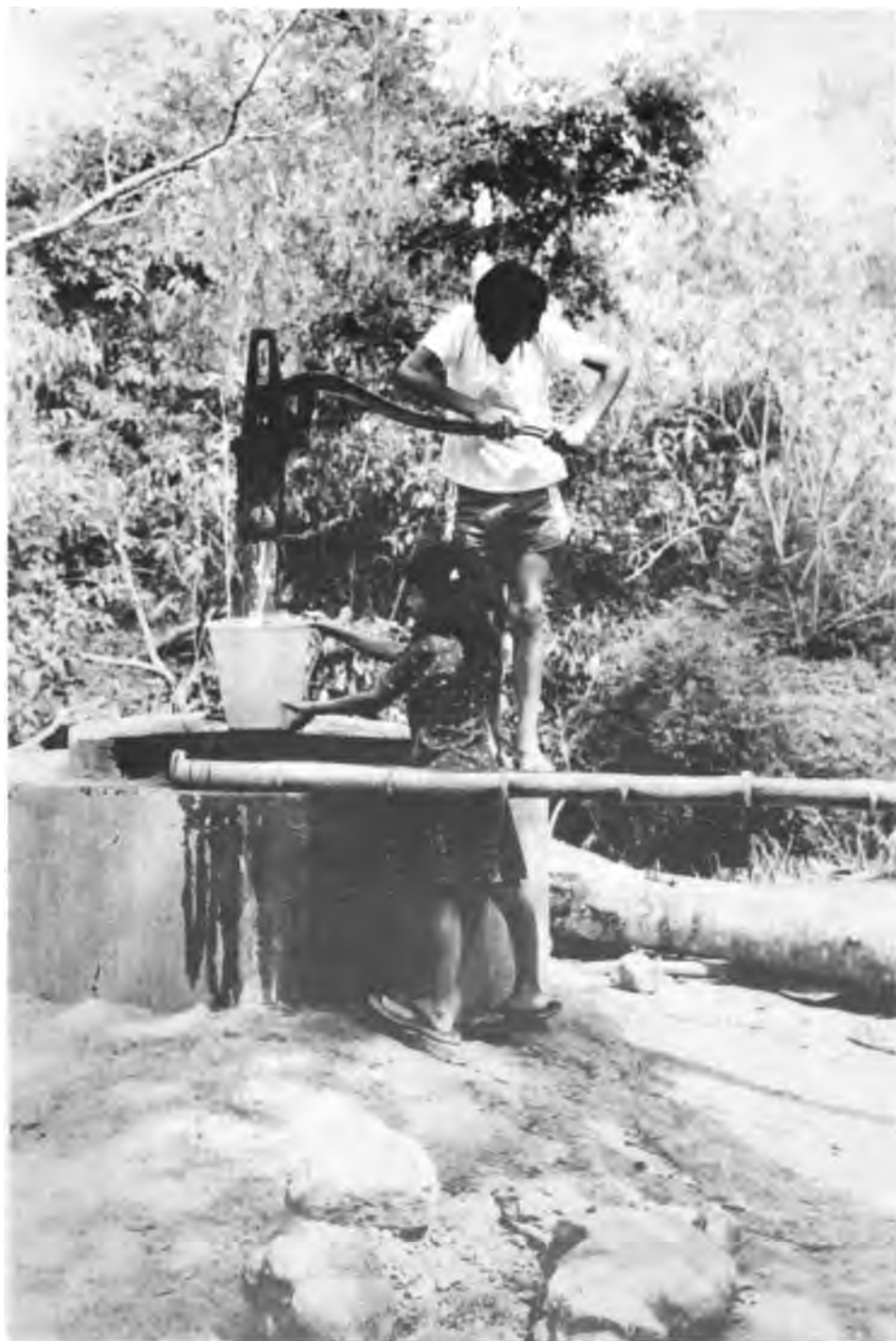
La construcción de pozos someros es una alternativa para dotar de agua a aquellas áreas en las cuales no existe una fuente que permita construir un abasto de agua (PDRI Jipijapa).
