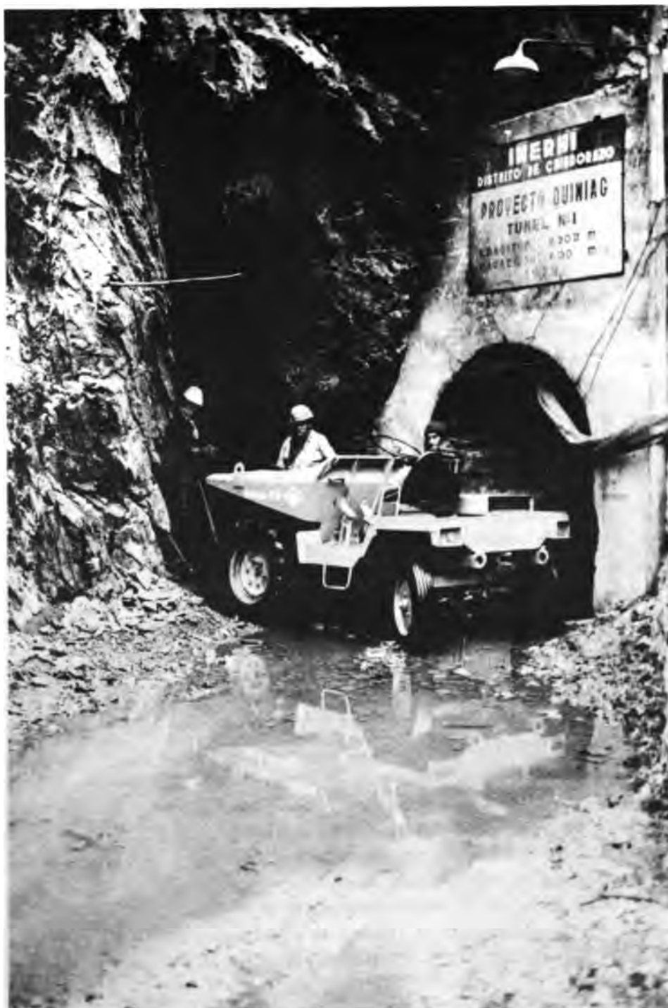
Fue necesario abrir un túnel de 2.200 mts. de longitud para permitir hacer una realidad el programa de riego (Proyecto Quimiag-Penipe).
