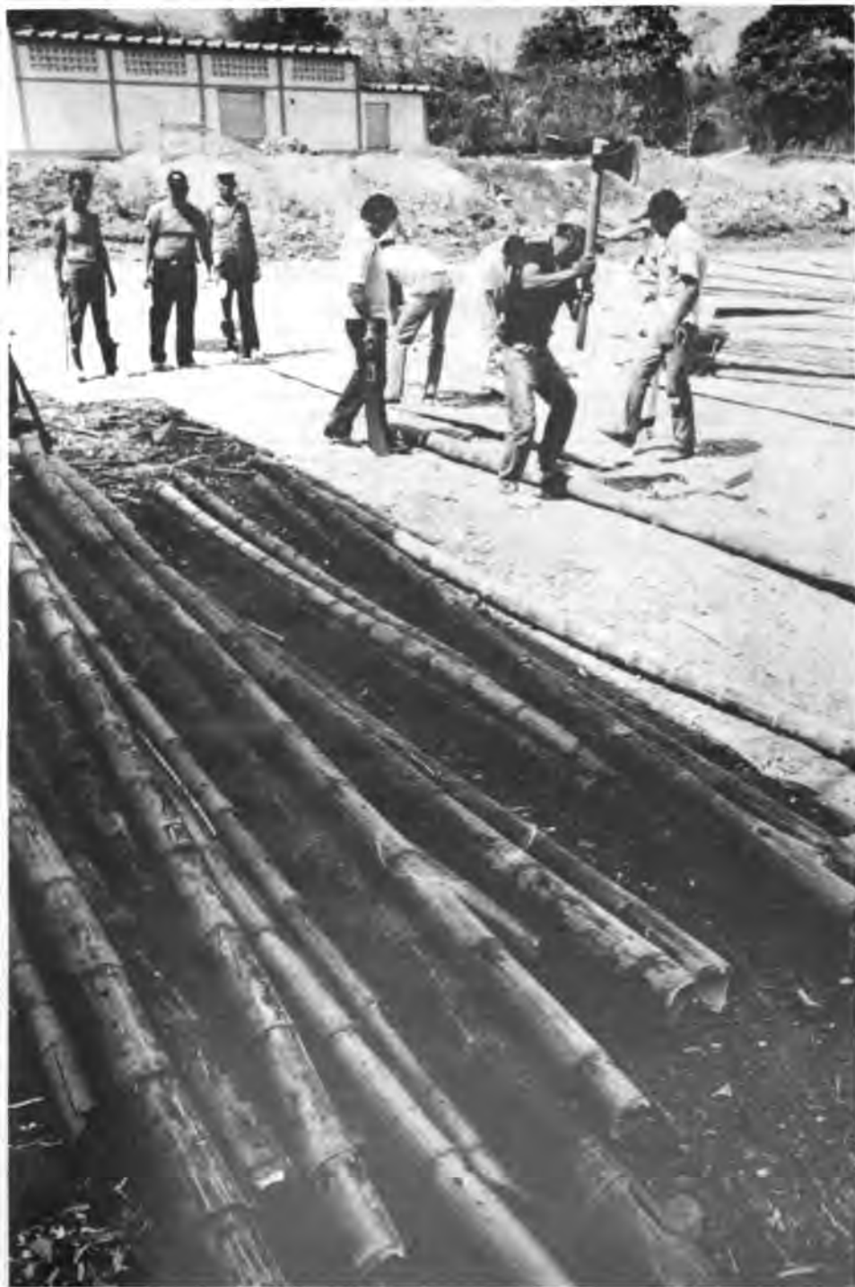
La participación campesina en las diferentes fases de una obra, incluida la ejecución garantiza su éxito y reduce notablemente los costos de construcción (PDR I Jipijapa).
