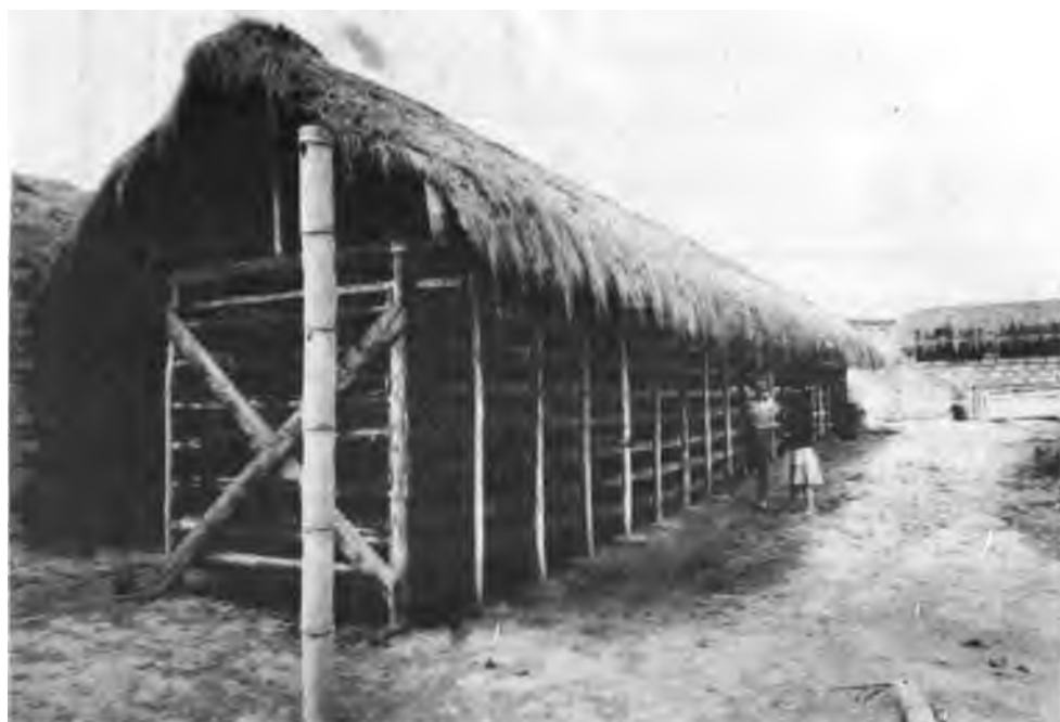
La construcción de silos para almacenamiento de semilla mejorada de papa es un ejemplo de combinación de elementos de tecnología moderna y materiales propios de la región (Proyecto Salcedo).
