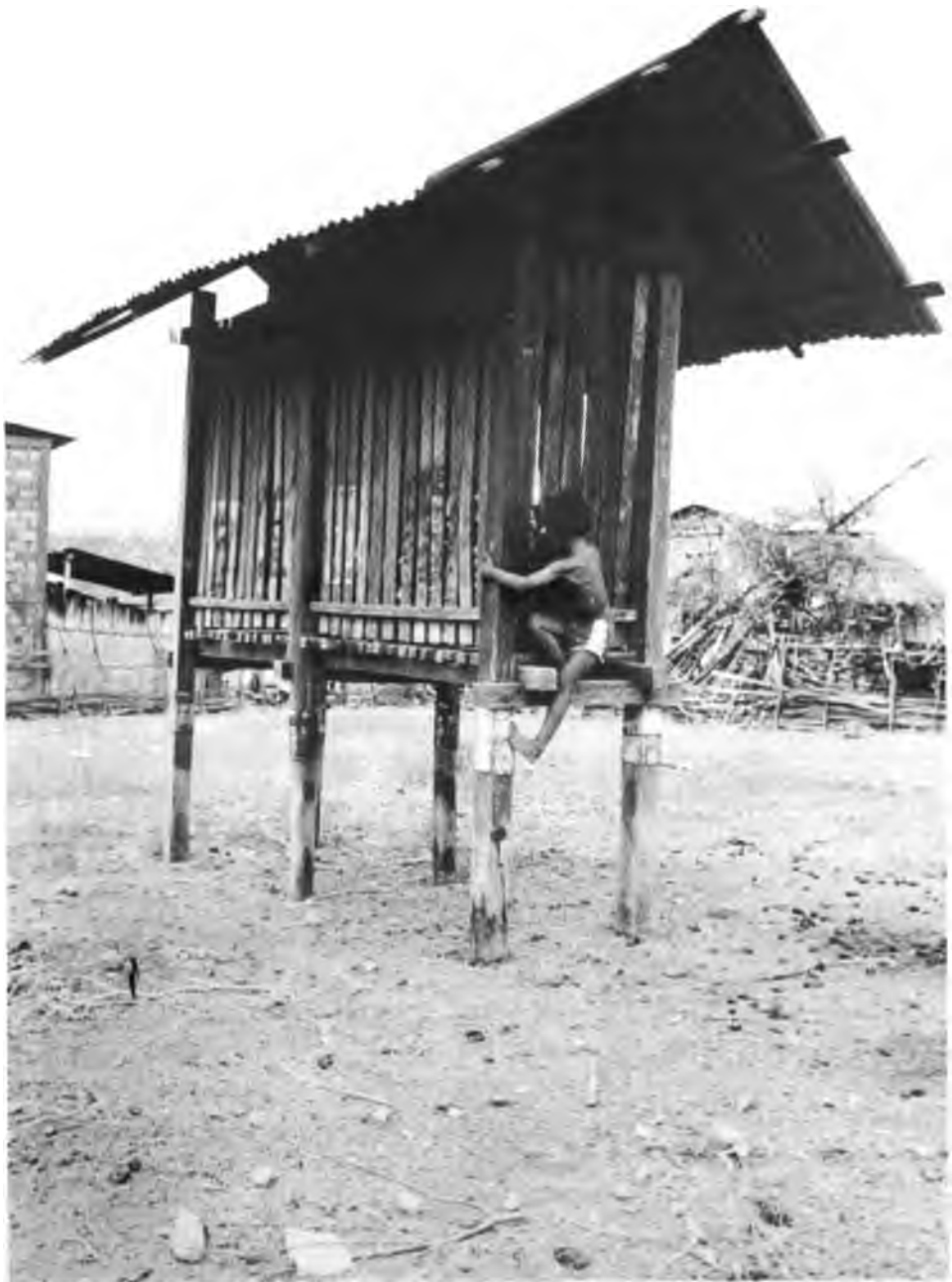
En diferentes comunidades se instalaron silos rústicos para almacenamiento de semillas de maíz, construidos básicamente con materiales de la zona.
