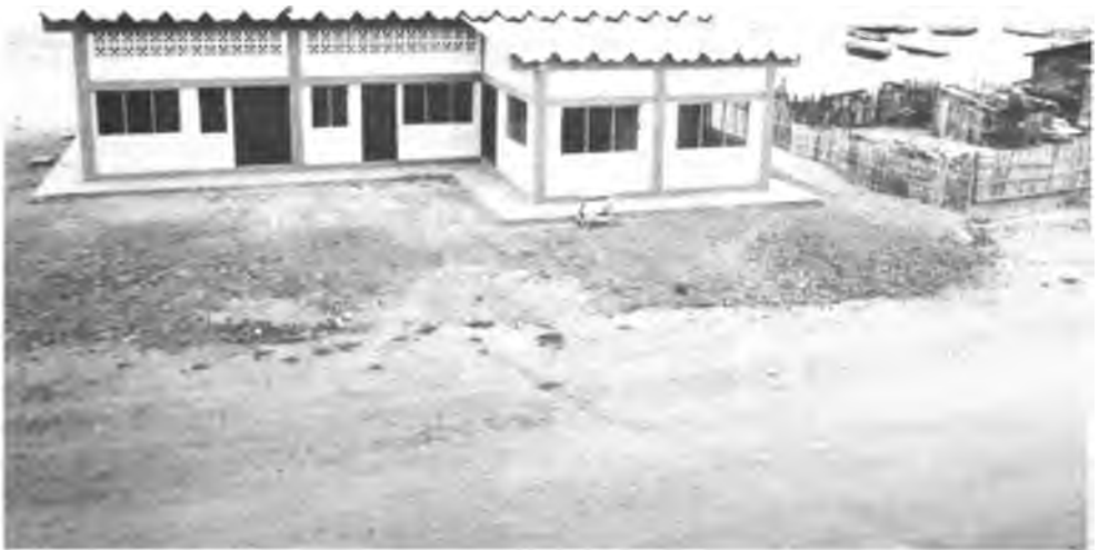
El Centro de Servicios de Puerto Cayo permitirá a los pescadores de la Parroquia tener un lugar para analizar sus problemas y arreglar sus equipos (PDRI Jipijapa).
