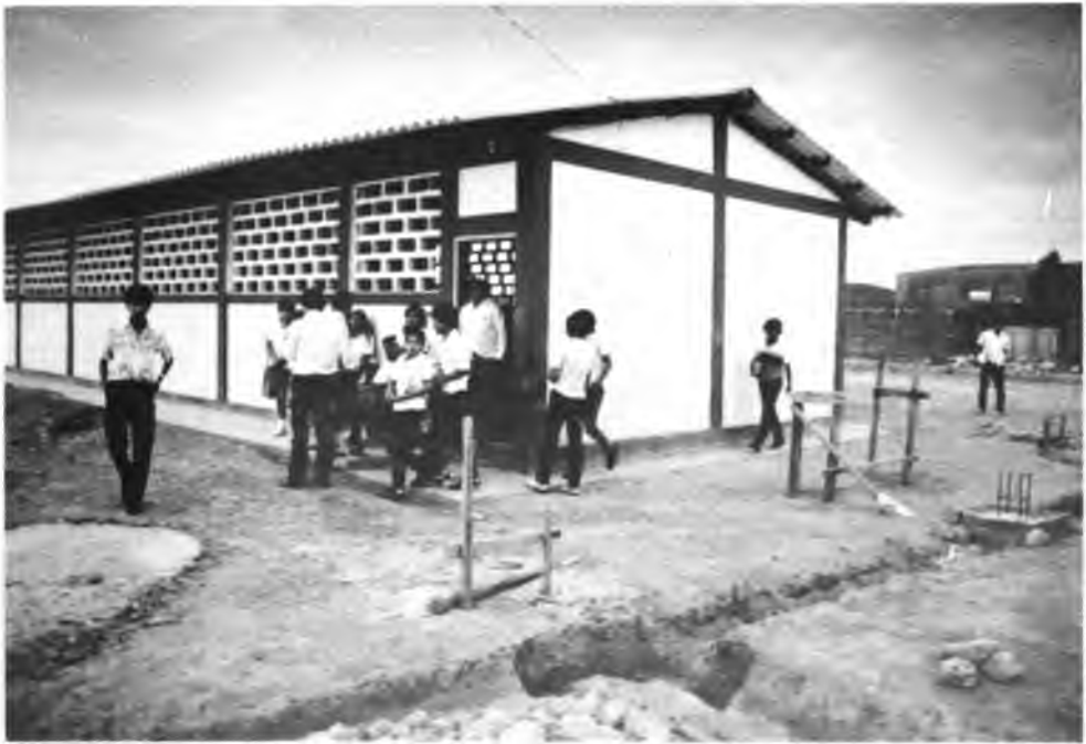
El proyecto hizo un gran esfuerzo para construir, adecuar y equipar locales escolares (PDRI Jipijapa).
