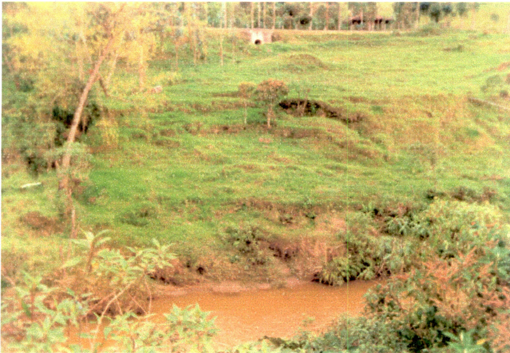
Desprendimientos Costado de la carretera a Pasto.
