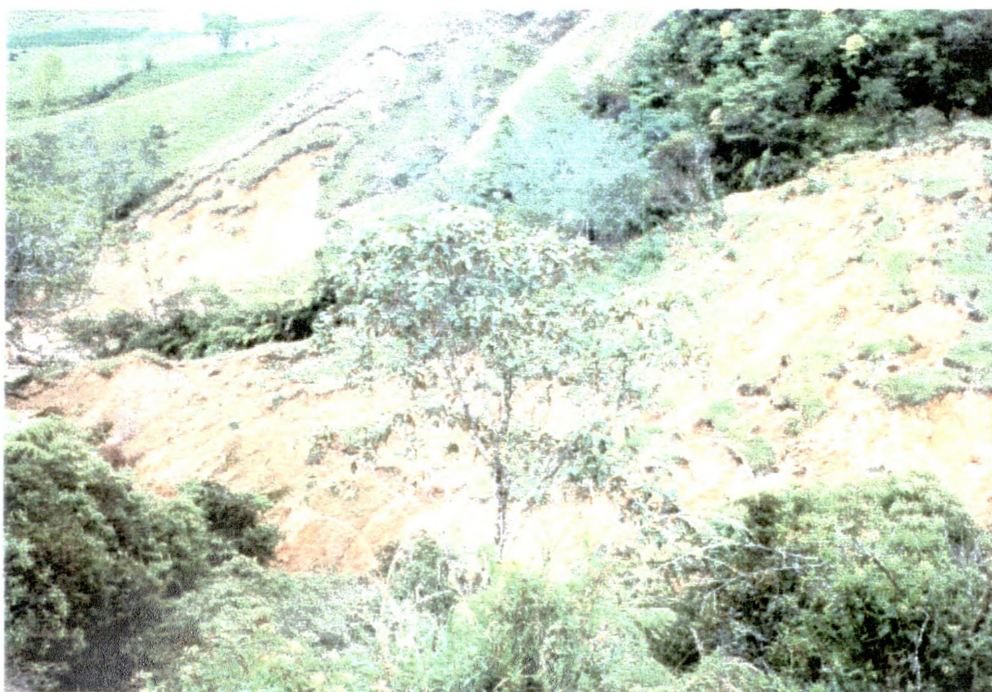
Falla, quebrada El Cedro.
