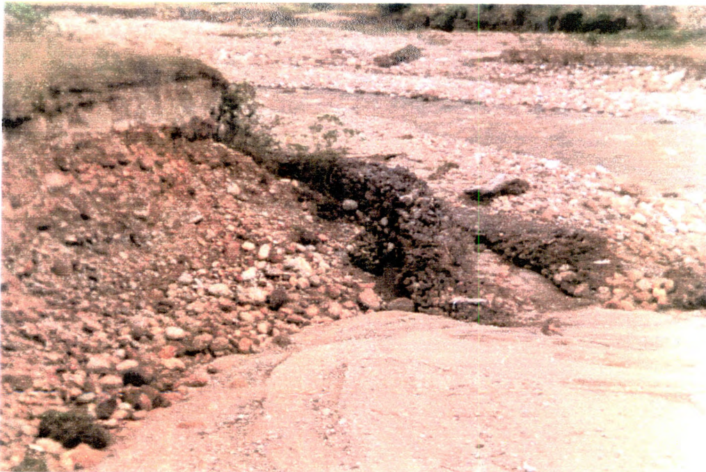
Muro en Gaviones, Río Putumayo.
