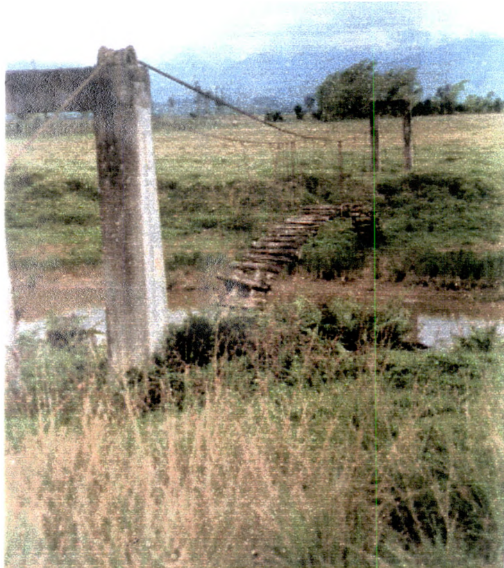
Puente Peatonal sobre Cauce Viejo Río Putumayo.
