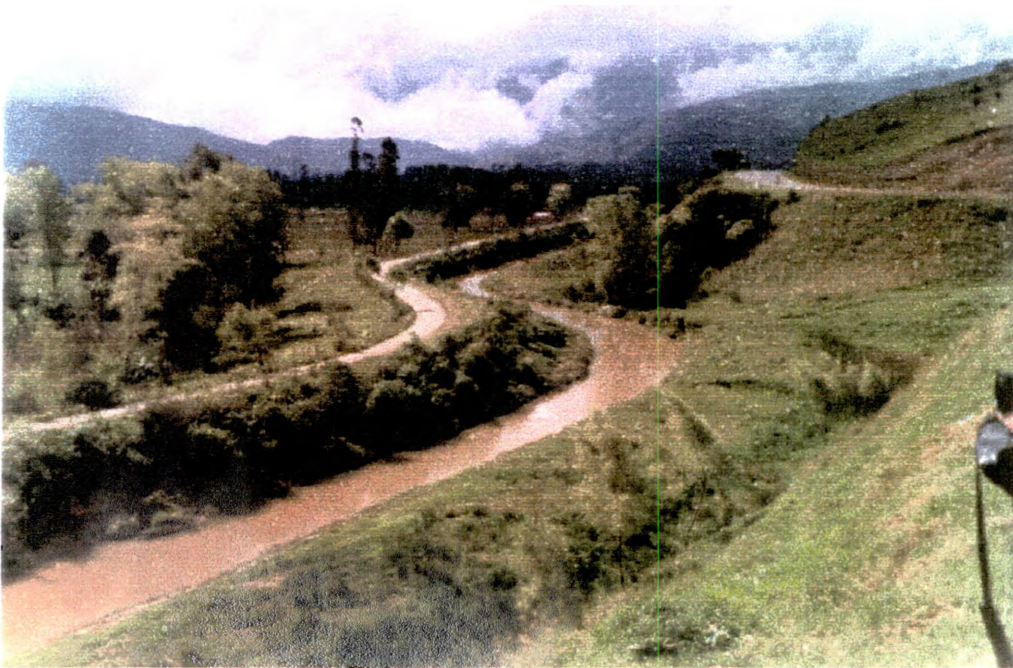
CANAL D, (Vista desde carretera a Pasto)
