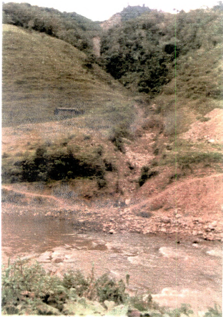
Quebrada El Edén, Erosión con obras de Control.
