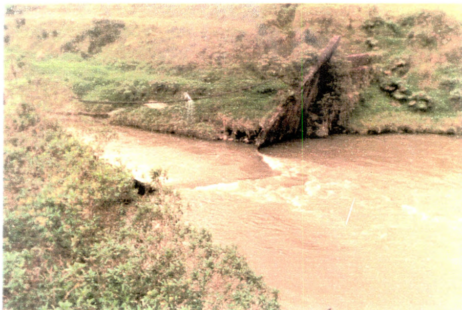
Estructura cambio de nivel, Canal A
