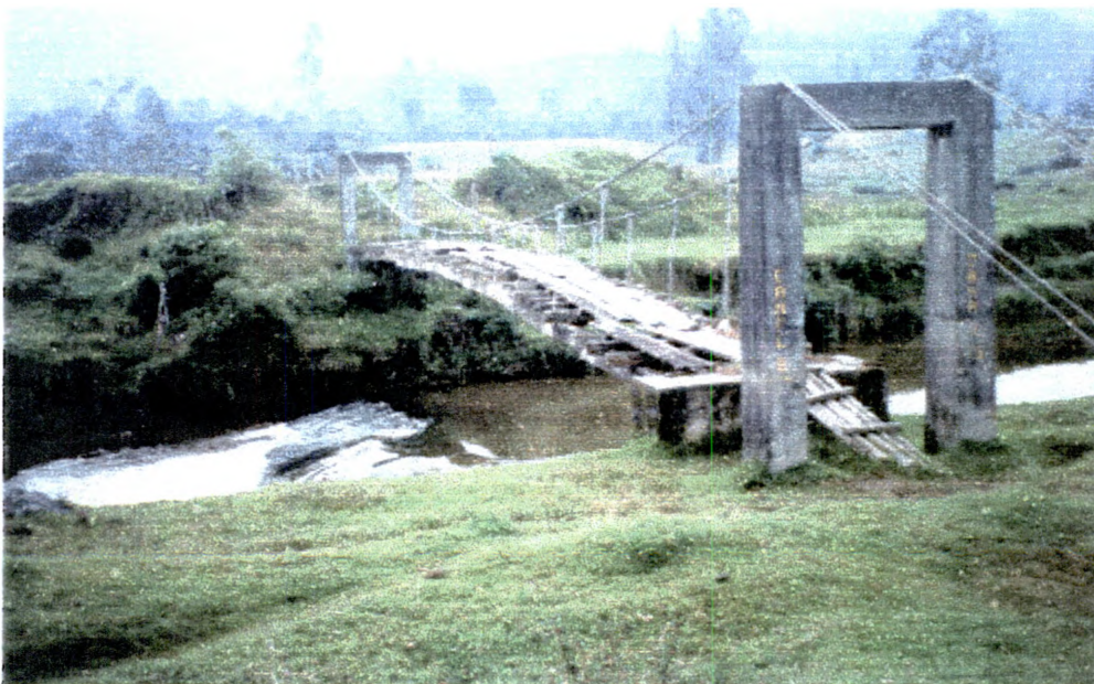
Estructura control de nivel puente wilker, Canal B.
