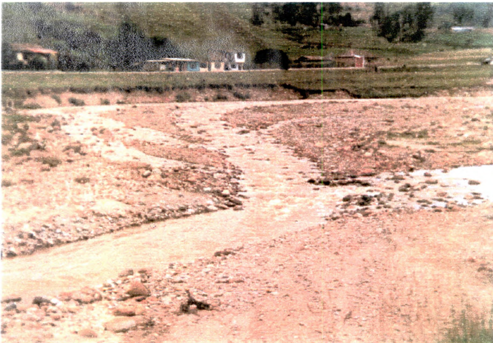
Río San Pedro, zona de construcción y reparación Muro, Canal D.
