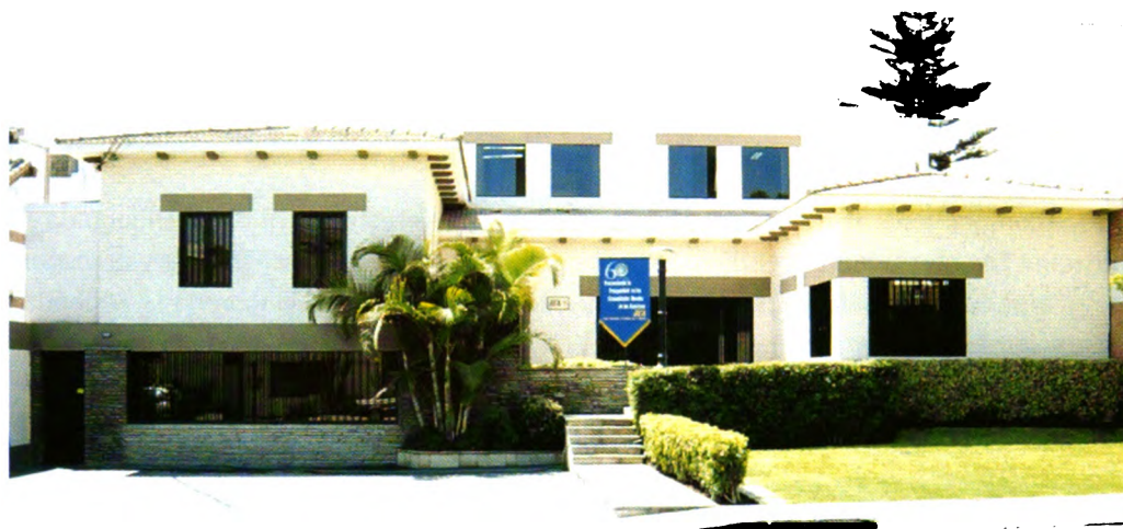
Vista del frontis de la Oficina del IICA - PERÚ.
