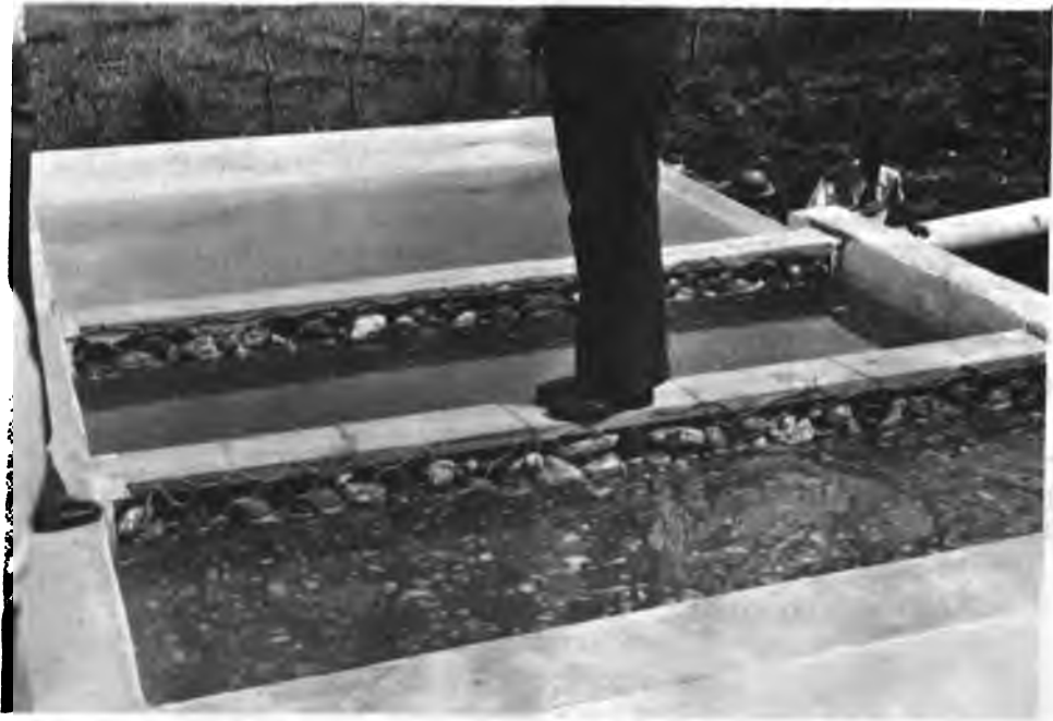
Figura 2. Filtros del Tanque de Calibración, Cámara de Aguas Arriba.
