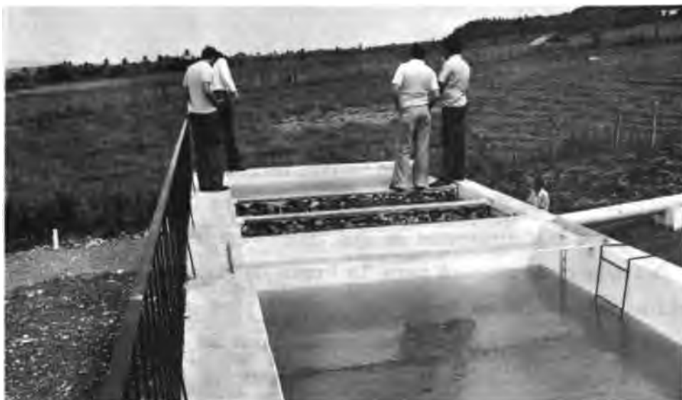
Figura 3. Tanque de Calibración, Cámara de Aguas Abajo.
