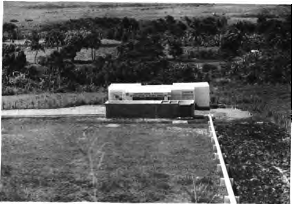
Figura 1. Laboratorio de Hidráulica, Tanque de Calibración de molinetes y tubería de alimentación del mismo.
