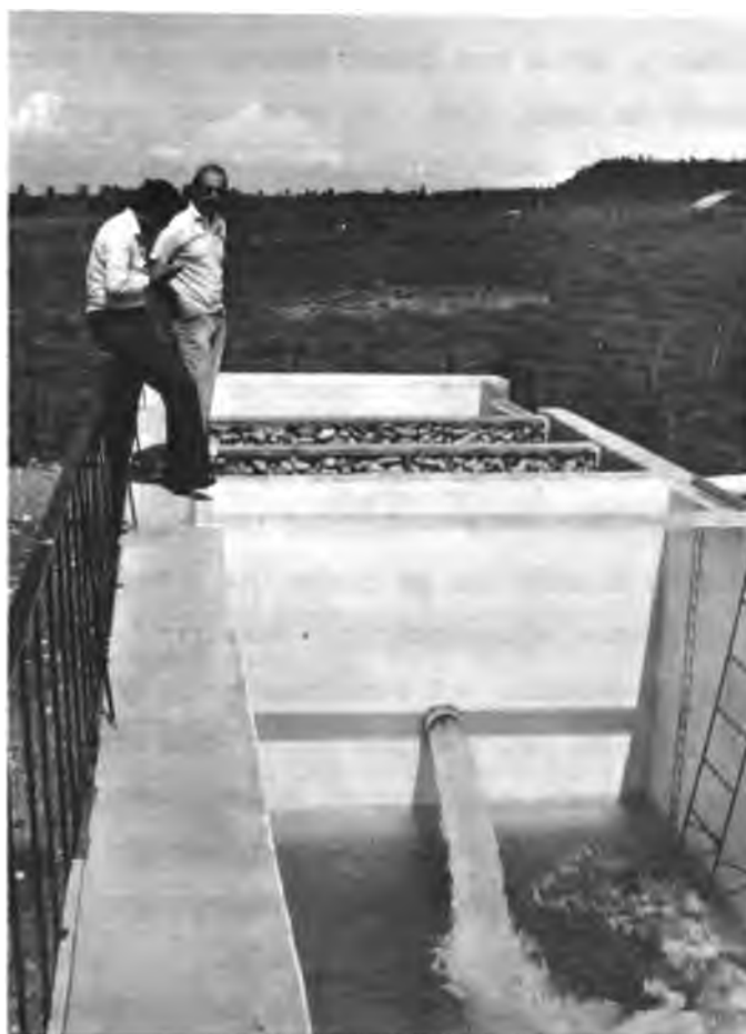
Figura 4. Tanque de Calibración, Vista de Chorro Libre.
