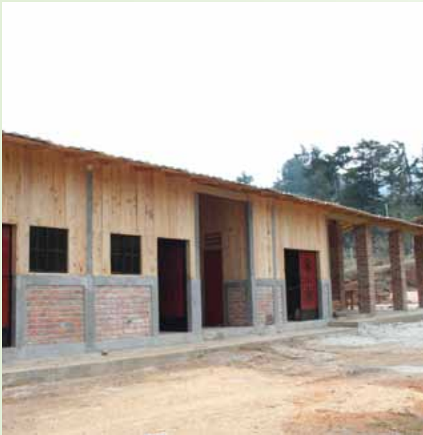
Construcción de la Plaza Agroturística como parte del Proyecto Fomento Agroturístico de la ZACHA
