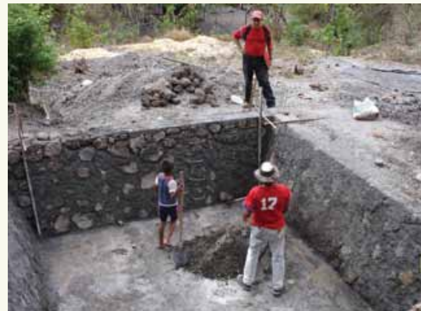
Estructuras de concreto para la recolección de aguas lluvias en las zonas más secas de El Salvador.
