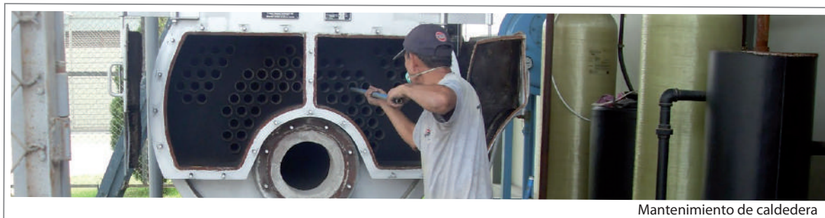
Mantenimiento de caldera
