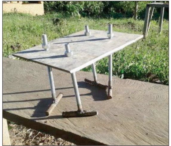
D. Anclaje de columna
