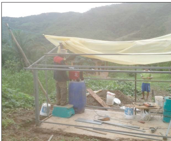
C. Armado de la estructura
