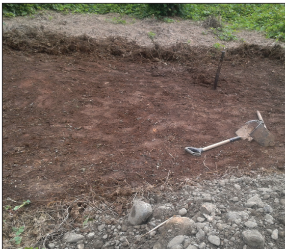
A. Deshierbado y nivelado del terreno
