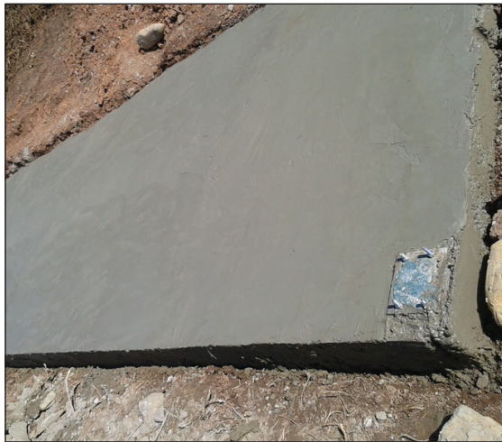
E. Vaciado completo del concreto
