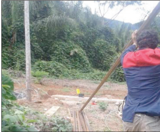
C. Armado de la estructura
