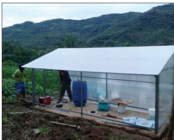
E. Ensamblado del techo
