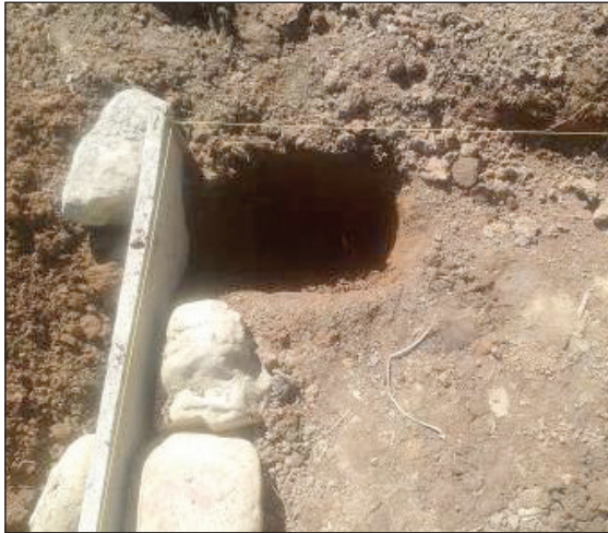
C. Excavación para montaje de anclaje
