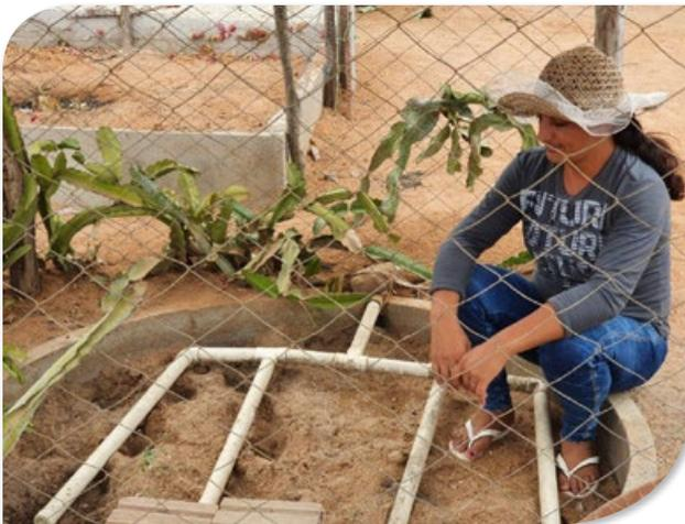
Durante a construção do anel, passe óleo queimado na forma para que o cimento não grude. Para cada anel utilize o traço de 7 latas de areia, 5 latas de brita e um saco de 50 kg de cimento. Coloque a massa na forma, distribua bem e compacte para não precisar rebocar.
