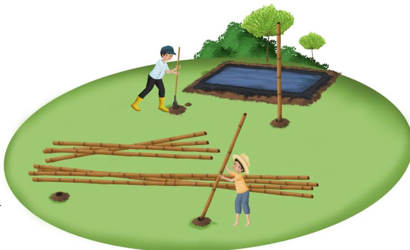
**f) La estructura del techo** debe contar con 8 varas de bambú de 4 m de largo y 4 varas de bambú de 7 m de largo.
