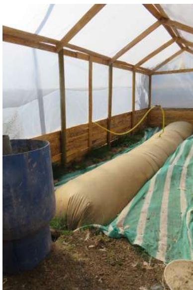
6. IDMA Buin, en la RM. Este proyecto no prosperó, aunque se tenía la intención de instalar un biodigestor con fines educativos. El sistema para mantener la inercia térmica presentaba un diseño deficiente: se planificó el uso de tuberías de polipropileno que, en comparación con las de PVC, presentan hasta 20 % menos pérdida de calor, lo cual, en este caso, resultó desfavorable, por lo que no fue posible avanzar con el proyecto.
