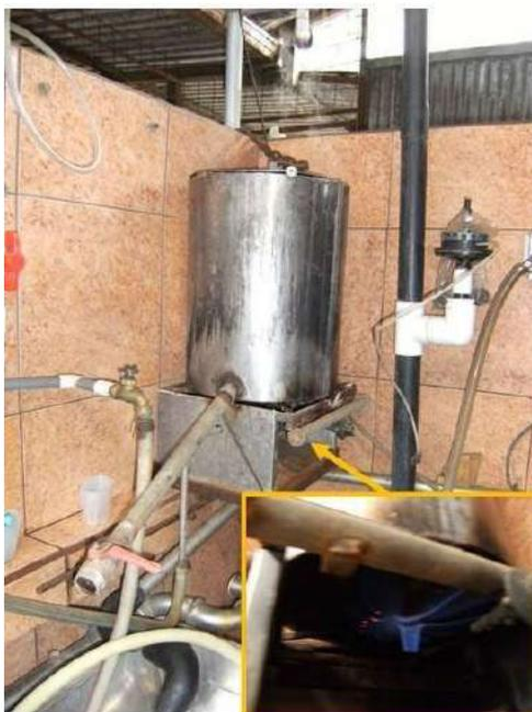
El calentador de paso (calefón) es una tecnología interesante, pues el equipo se enciende semiautomáticamente en el momento en que empieza a circular el agua. Su funcionamiento es sencillo: el biogás se quema, generando una llama, y cuando el agua fluye por medio de un serpentín/intercambiador de calor, esta se calienta. Presenta una eficiencia térmica alta (>80 %), que logra llevar el agua de la temperatura ambiente hasta los 55 °C (temperatura estándar para comparar calentadores de paso).
