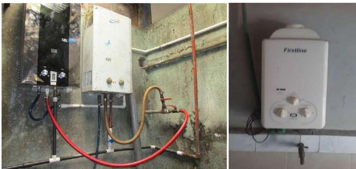
Nota: Izquierda: en Costa Rica, calentadores empleados en la limpieza de equipos en una finca lechera (el equipo de la izquierda opera con biogás y, como respaldo, otro equipo, que funciona con propano). Derecha: en Cuba, adaptación de un calentador eléctrico para su uso con biogás.
