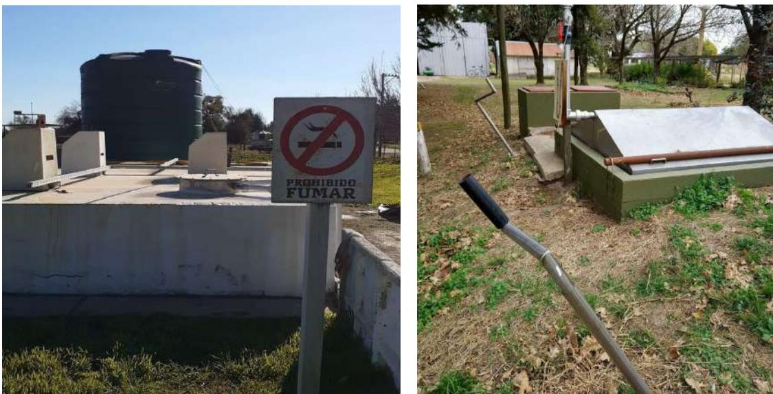
Nota: Ambos biodigestores se encuentran enterrados a más de dos metros de profundidad para garantizar el aislamiento térmico.
