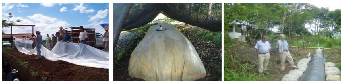
Nota: A la izquierda, el Prof. Botero instala un biodigestor en la Universidad EARTH, circa 2002. A la derecha, un biodigestor tipo Taiwán se halla en operación. Abajo, el Prof. Botero, junto con el Dr. Thomas Preston, posa cerca de un biodigestor tipo Taiwán.
