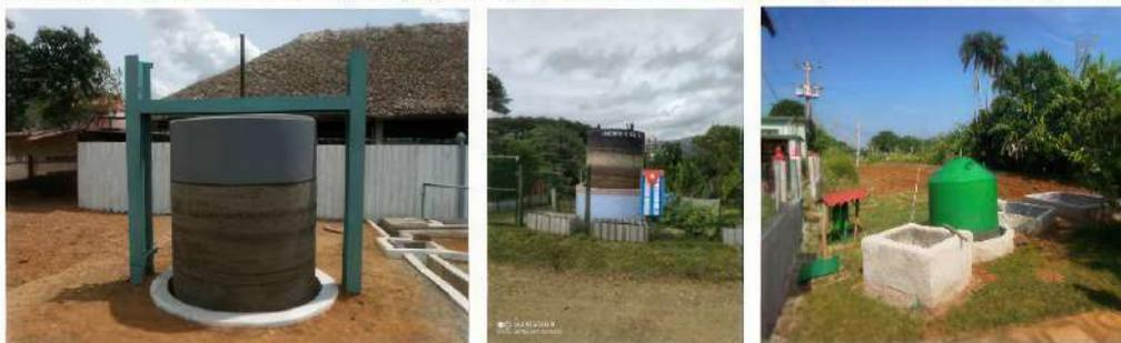
**Biodigestores de cúpula fija, de 12, 8 y 10 m<sup>3</sup> c/u, ubicados en los municipios de Manicaragua, Candelaria y B. Masó**
