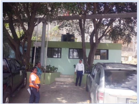
Después: Oficina de Cuarentena Agropecuaria en el Puerto de Haina Occidental.
