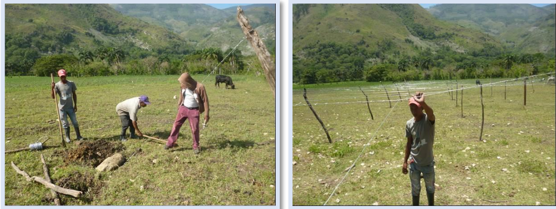
Labor de construcción de la estructura para tayota en Hondo Valle.
