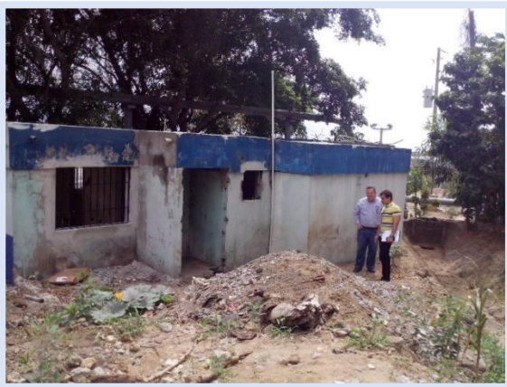
Antes: Oficina de Cuarentena Agropecuaria en el Puerto de Haina Occidental.
