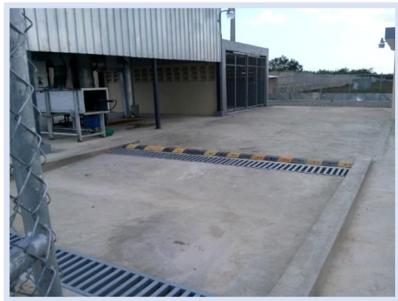
Rodiluvio en planta de incineración construida en el AILA
