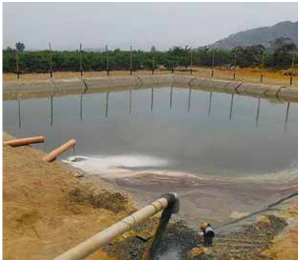
Sistema de lagunas de oxidación.
