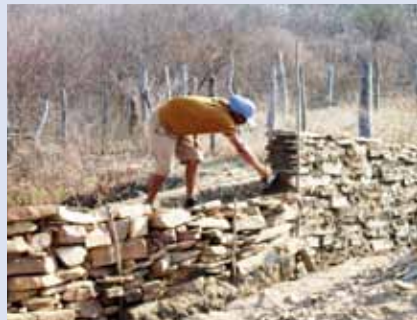
Foto 02 - Construção de barragem em pedra seca.
