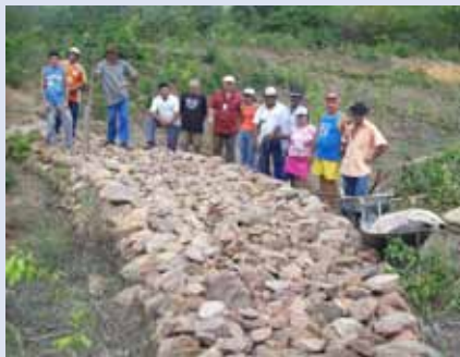
Foto 02 - Atividade coletiva para construção de barragem sucessiva.
