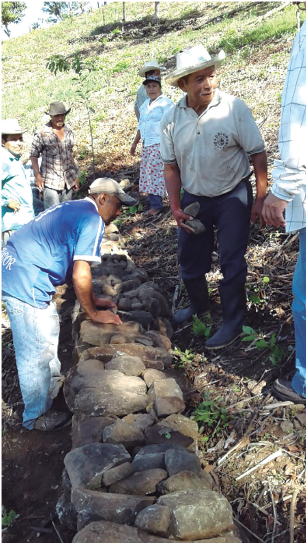
Foto 10. Las barreras muertas de piedra miden aproximadamente 50 cm de alto y 40 cm de ancho.
