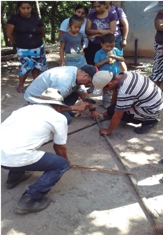
Foto 1. Se clavan las varas juntas, a una distancia de 10 cm del extremo.
