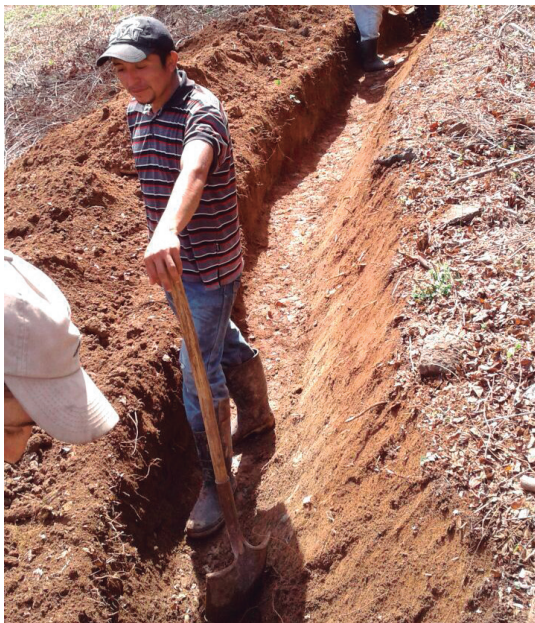
Foto 4. Productores participantes en el Proyecto Asociatividad, Resiliencia y Mercados construyen una acequia de infiltración.
