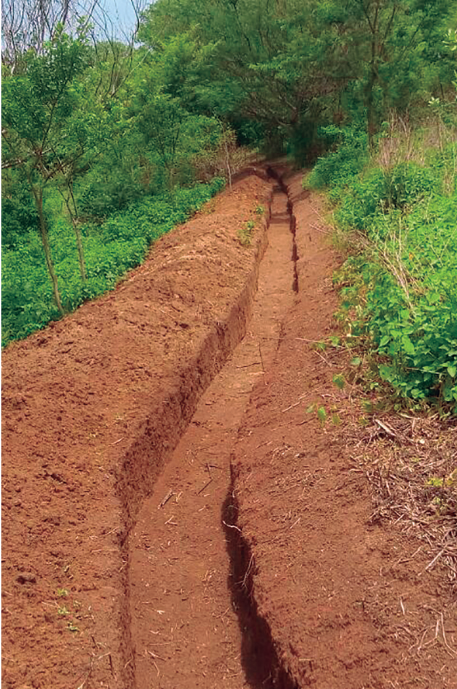
Foto 5. Se deben realizar labores de mantenimiento dos veces al año para mantener la acequia limpia.
