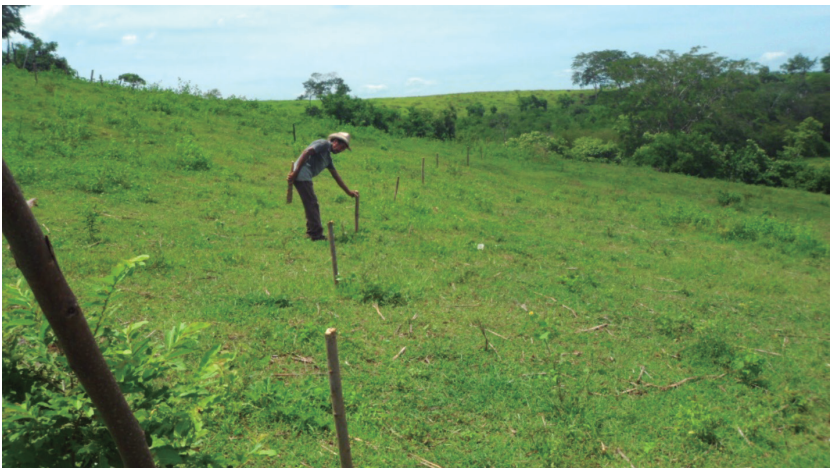
Foto 3. Al ojo, se corrige la alineación de las estacas de la curva a nivel.
