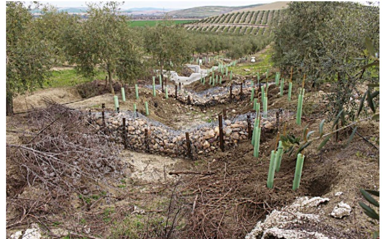
Diques de retención en una cárcava permanente. Foto: Red Control Erosión
