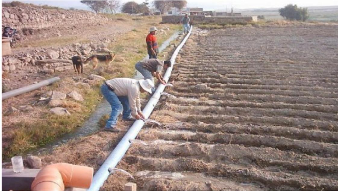
Apertura de multicompuertas. Foto: Point de tecnificado por gravedad.
