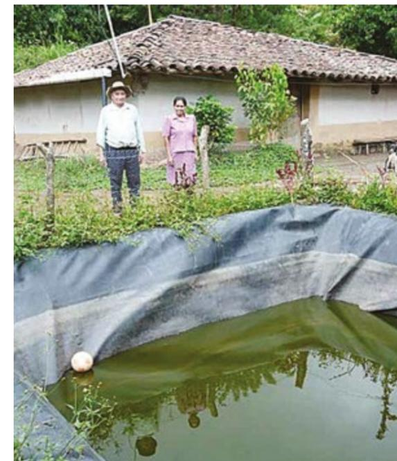
Del manejo de la tecnología dependerá la vida útil de la misma. Cuando se tengan excesos de lluvia, se debe utilizar la tubería de drenaje; y en épocas de sequía, se debe proteger el plástico que recubre la fosa (se puede utilizar material vegetal).
