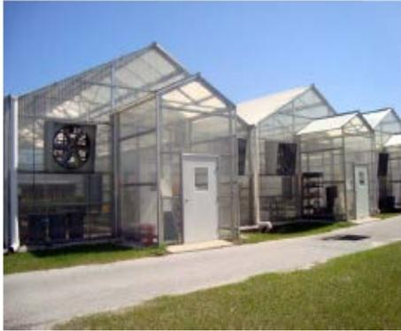
Los invernaderos son construcciones altas, herméticamente cerradas con materiales transparentes, diseñadas para cultivar o proteger temporalmente las plantas. El techo puede estar cubierto por plástico, vidrio, fibra de vidrio, o láminas corrugadas de policarbonato, pudiendo incluir aberturas para una ventilación pasiva. A su vez, las paredes frontales y laterales pueden ser cubiertas con los materiales antes descritos o por mallas anti-insectos
