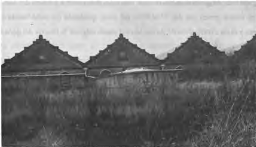
Figura 5. Captación de agua de lluvia en los techos de zonas industriales. (Foto: M. Anaya).
