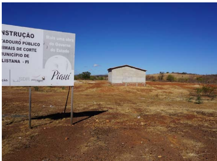
Foto Nº 08 – O futuro (?) abatedouro /frigorífico de Paulistana.
