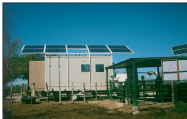
Imagen 7. Sistema fotovoltaico de la quesera móvil.
