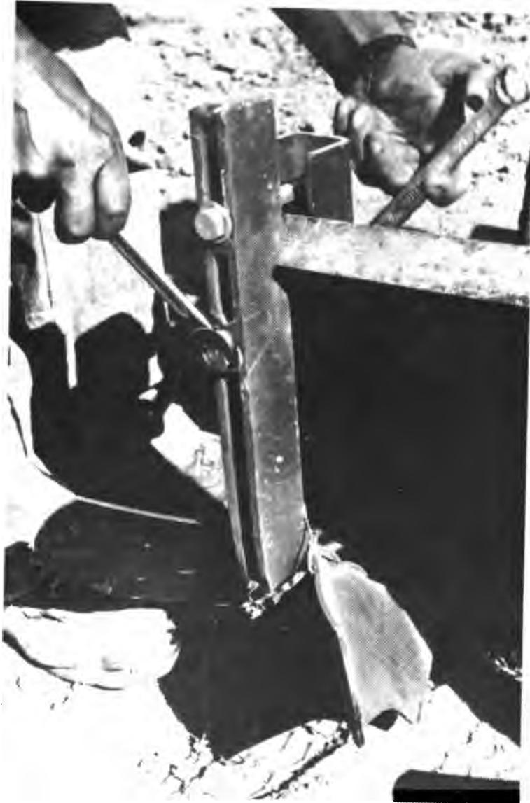
**Figura 18. Conexión de un surcador en la barra portaimplemento del multicultor ICAT-INIA.**
