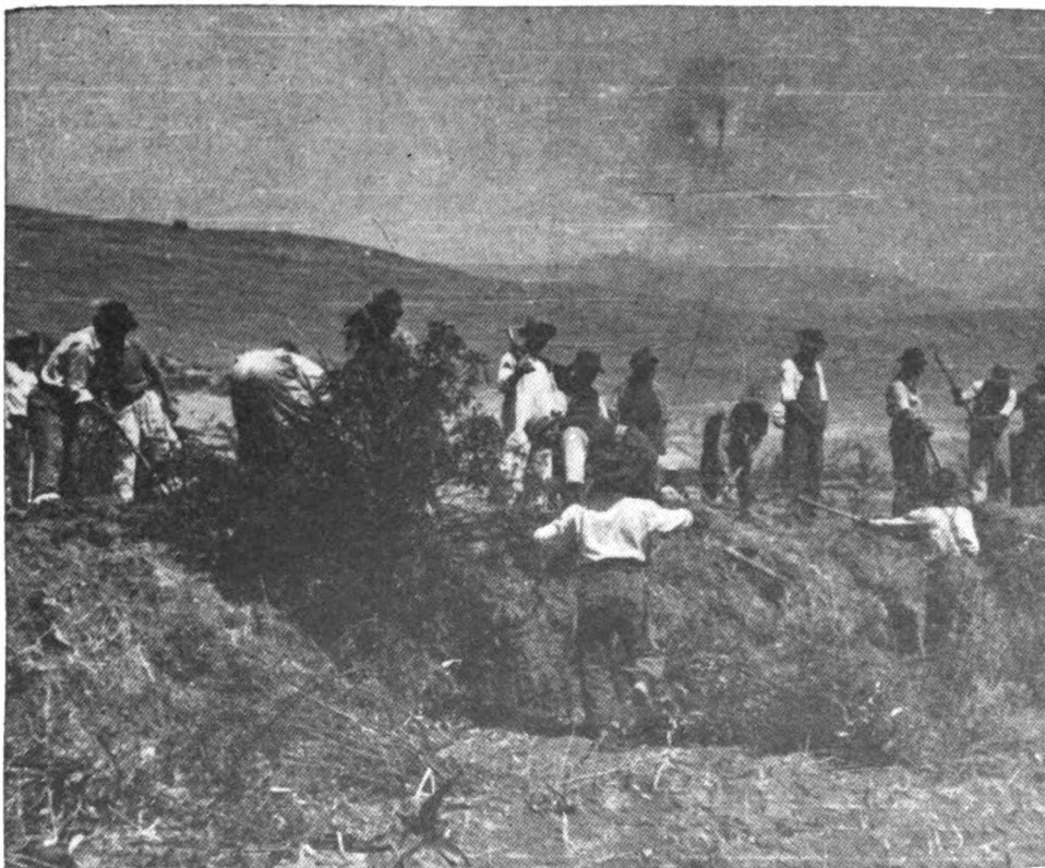
Foto 11. Construcción de un campo por faena comunal, 1954
