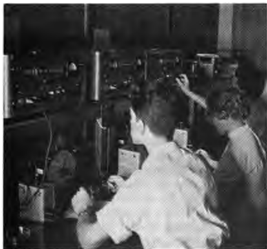
Una clase de técnicas de isótopos radiactivos tomando medidas de radiactividad de muestras de plantas con tubos geiger, y escalímetros
