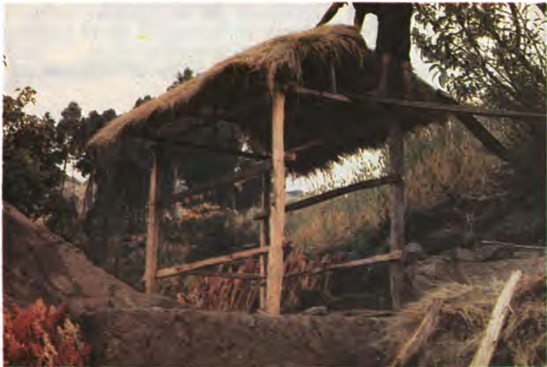
Construcción de un almacén rústico mejorado, para quinua.
