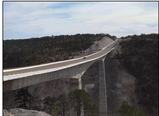
Figura 13. Puente 'Baluarte', el más grande y profundo de Latinoamérica.
