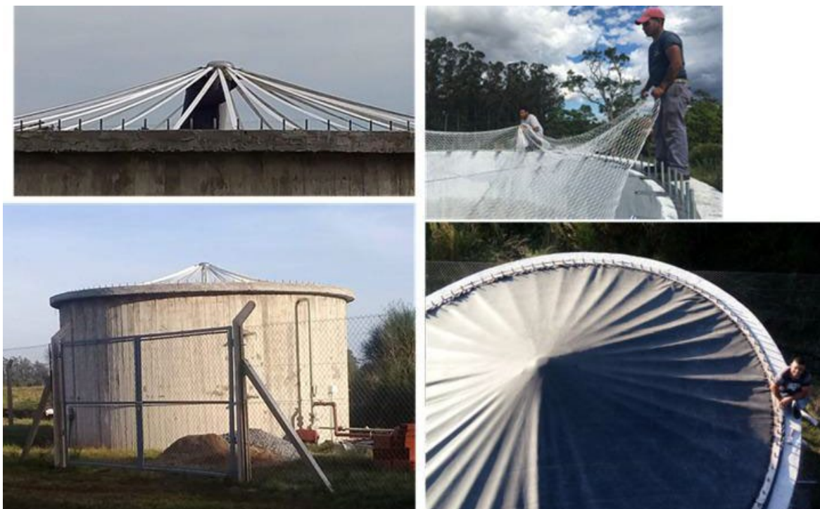
Ilustración 66. Biodigestor de Los Pinos
