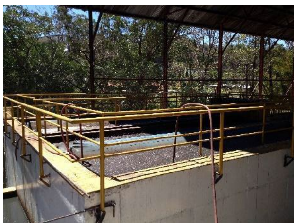
Ilustración 6. RAFA instalado en el beneficio de café de Volcafé, Heredia, Costa Rica
