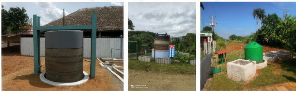
Ilustración 20. Biodigestores de campana móvil y cúpula fija de diferentes tamaños
