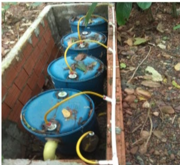
Ilustración 17. Biodigestores tipo caneca en serie, Reserva Natural Rancho Camaná, departamento de Meta, Colombia
