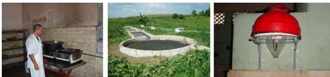
Ilustración 64. Cocina, biodigestor, conductor y lámpara de biogás en el motel Las Tecas, municipio Ranchuelo, provincia de Villa Clara, Cuba
