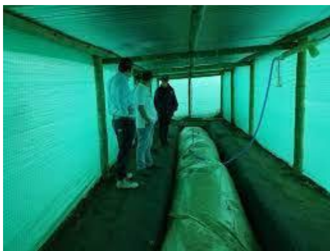
Ilustración 19. Biodigestor tubular instalado en el municipio de Bolívar, Valle del Cauca
