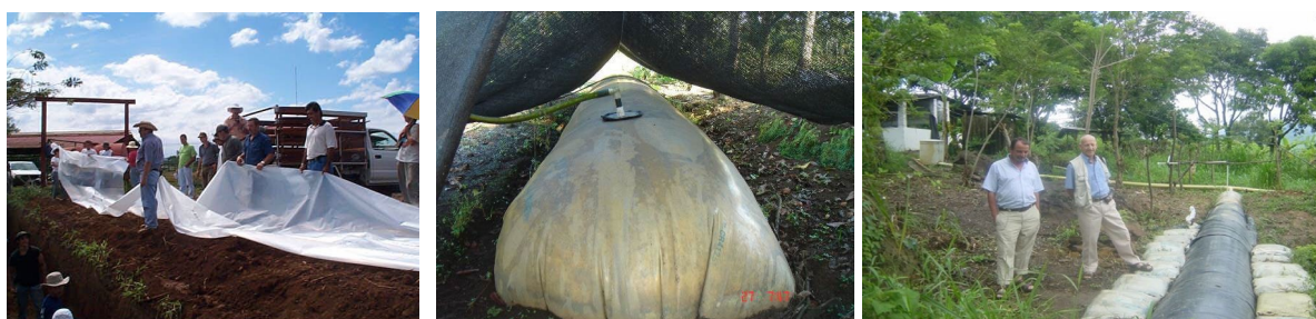
Ilustración 1. Biodigestor tipo Taiwán
