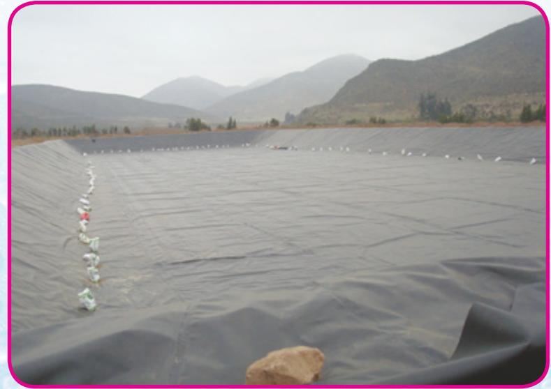
**Figura 20:** Proceso de colocación de la geomembrana.
