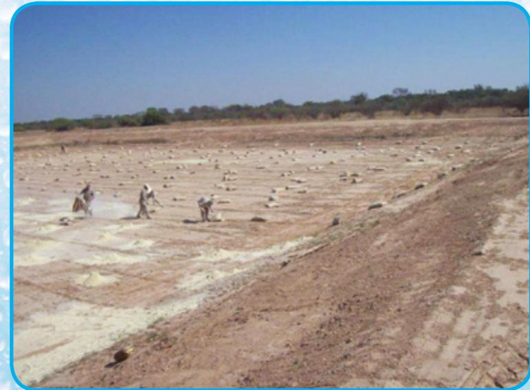
**Figura 18:** Distribución manual de bentonita sódica, para impermeabilizar la represa. Campo Experimental del INTA en Santiago del Estero (Fuente: Ingeniero Maro Bazán N. EEASE, Argentina)
