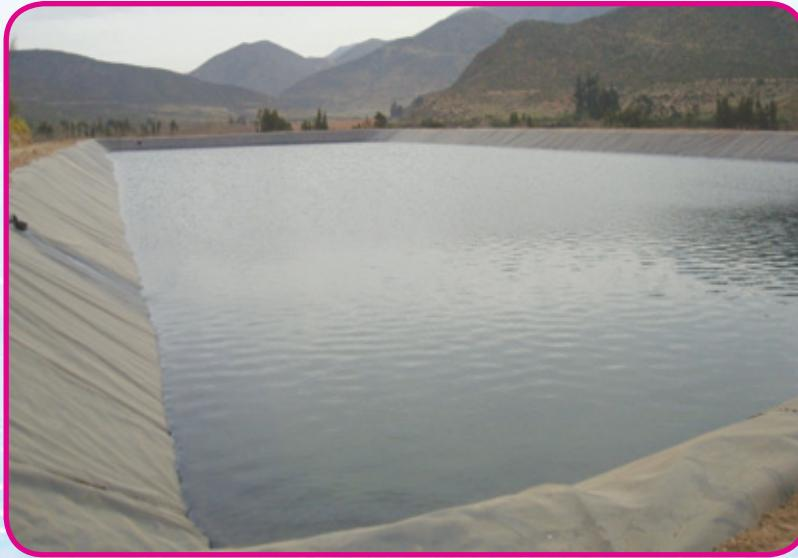
**Figura 19:** Estanque o reservorio revestido con HDPE de 1mm de espesor
