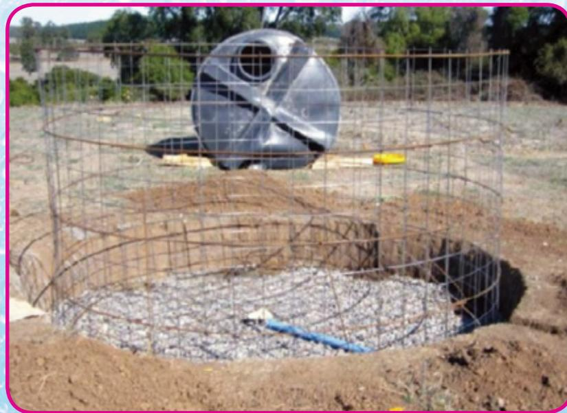
**Figura 6:** Estructura metálica del tanque de ferrocemento.
