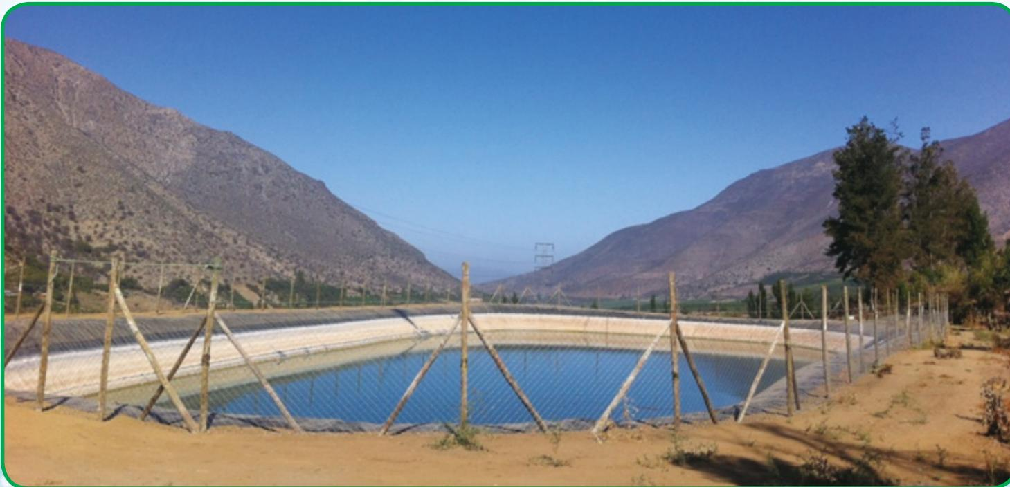
**Figura 31:** Tanque de acumulación de agua revestido con geomembrana.
