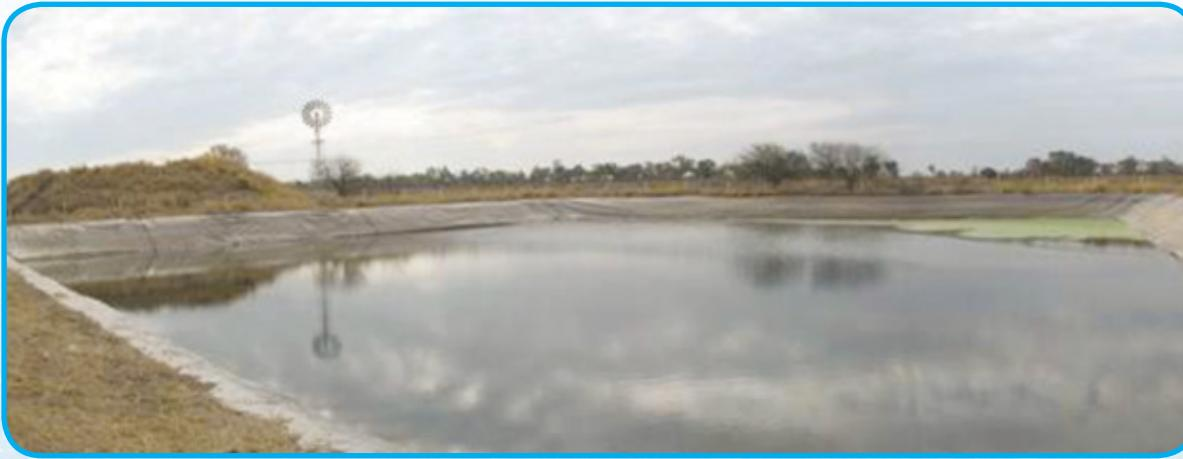
**Figura 16:** Represa recubierta con geomembrana de 1 mm (1.000 micrones) de espesor. Pampa del Infierno, Chaco. Argentina
