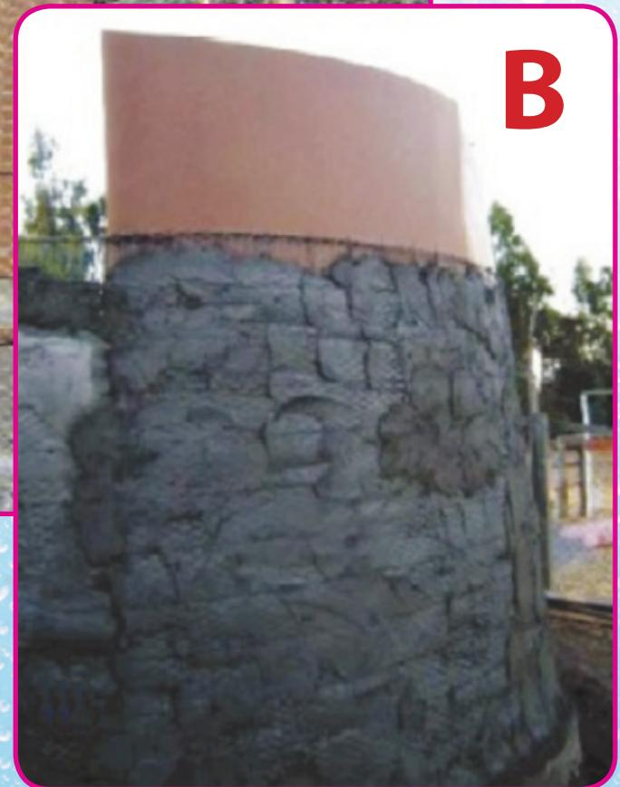
**Figura 7:** Revestimiento del tanque de ferrocemento.
