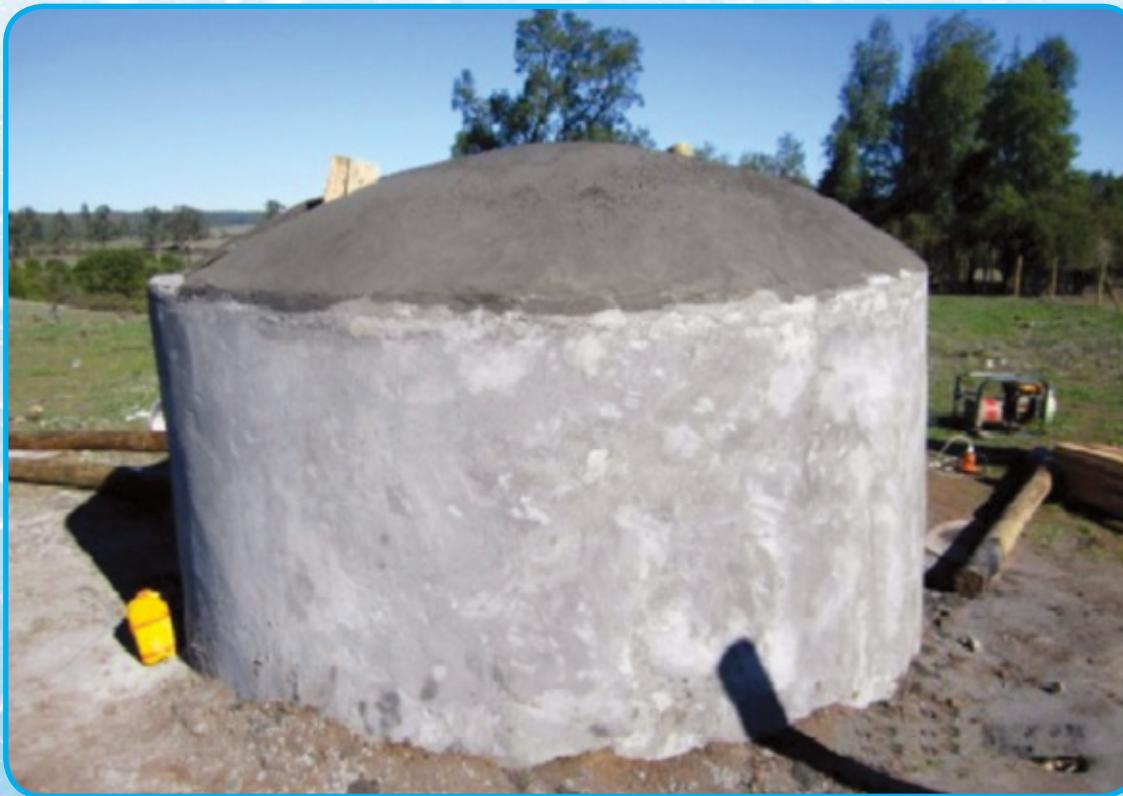
**Figura 5:** Forma cilíndrica del tanque de ferrocemento
