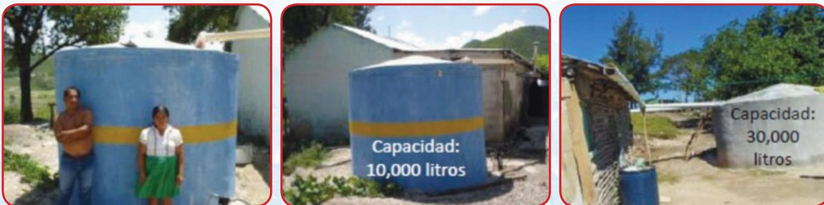
**Figura 10:** Construcción de cisternas de ferrocemento.
