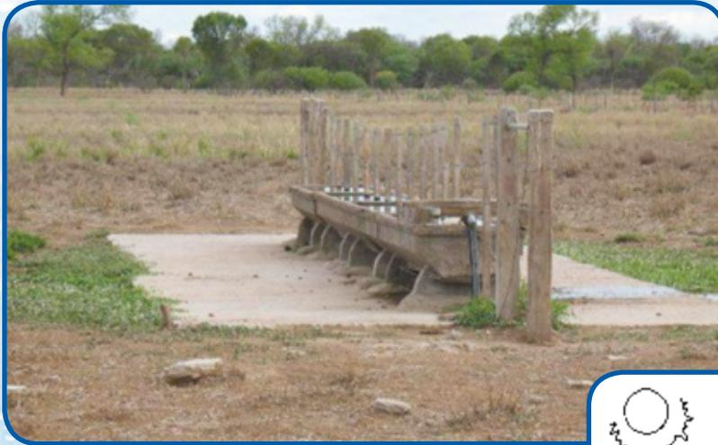
**Figura 24:** Sistema de bebederos con plataforma y separador. Quimilí. Santiago del estero (Fuente: M. Bazán N. EEASE, INTA, Argentina)
