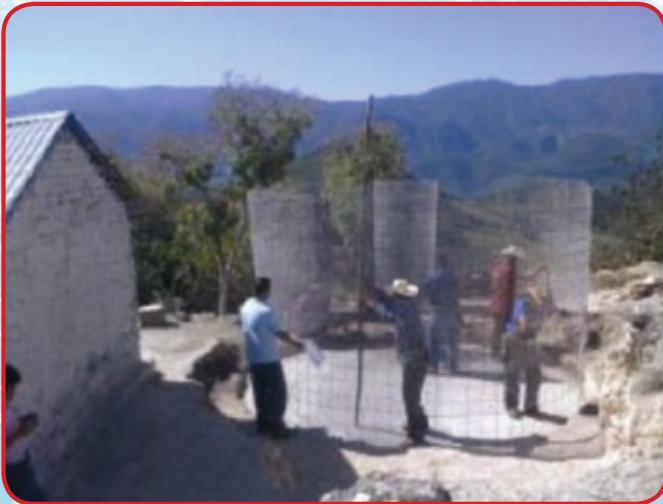
*Productores colocando el cilindro de la cisterna de ferrocemento, cerca del techo de la casa para aprovechar el agua de lluvia.*
