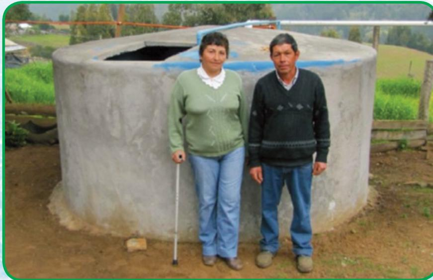
**Figura 4:** Estanque de ferrocemento alimentado con aguas lluvia.
