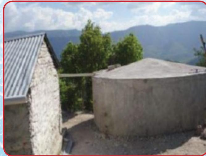
*Cisterna terminada con el sistema de cosecha y conducción de agua de lluvia desde el techo al depósito.*
