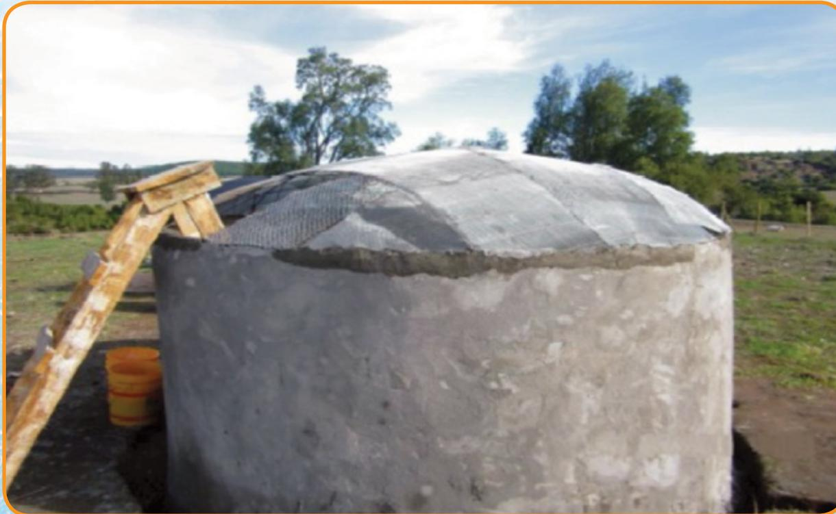
Si se llegan a producir filtraciones, se puede utilizar una pintura asfáltica, especial para impermeabilizar estanques o contenedores que estén en contacto con el agua, las cuales son fáciles de obtener en el comercio.
